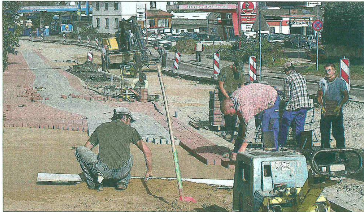
Fuß- und Radwege sowie Parkstreifen werden an der Westseite der Helmstedter Straße gepflastert.
